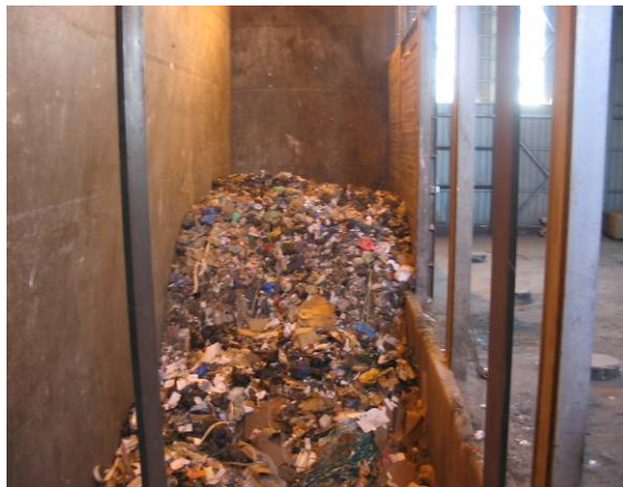
Fosse de réception des Ordures Ménagères
