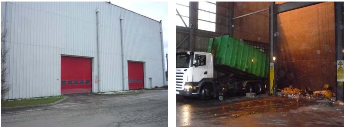
hall de réception des Ordures Ménagères
