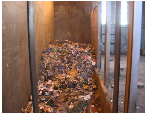
Fosse de réception des Ordures Ménagères
