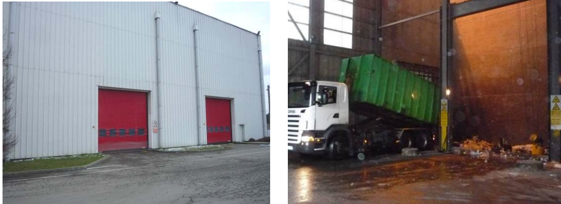
Hall de réception des Ordures Ménagères
