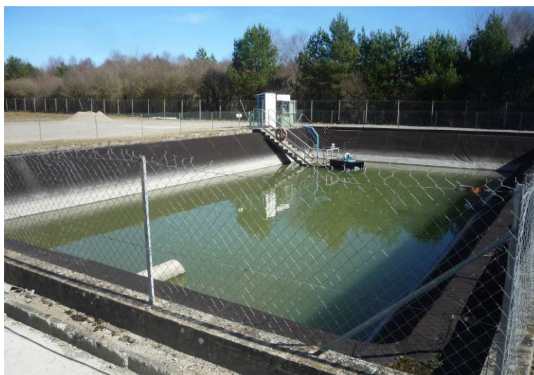
Lagune eaux industrielles 1
