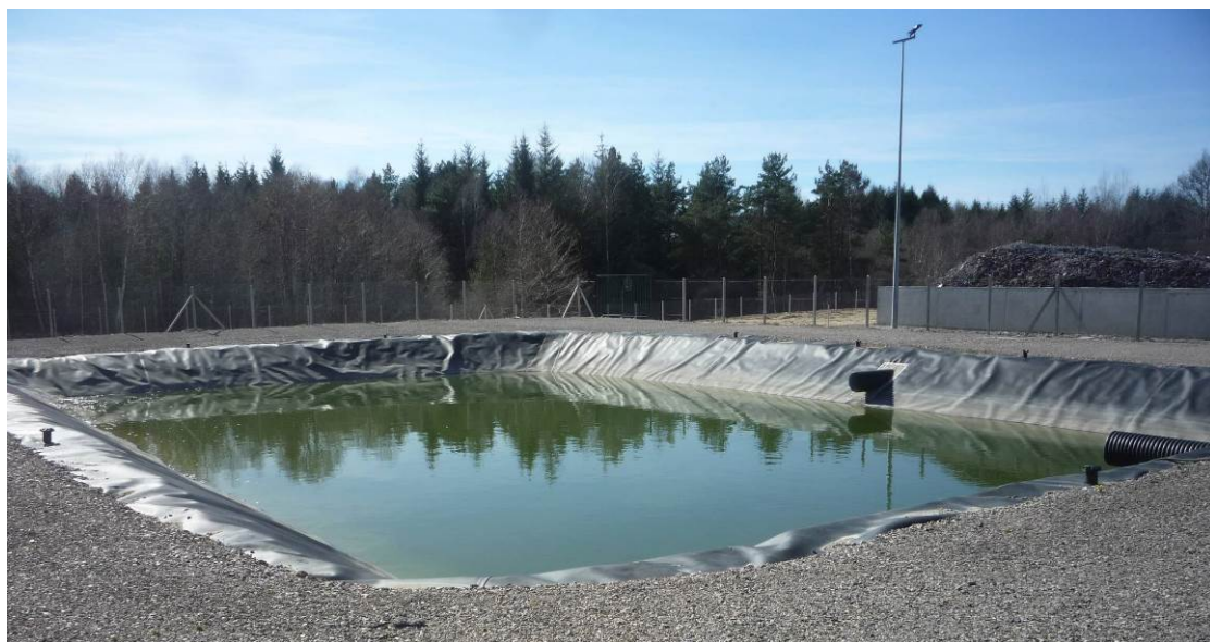
Lagune eaux industrielles 3
