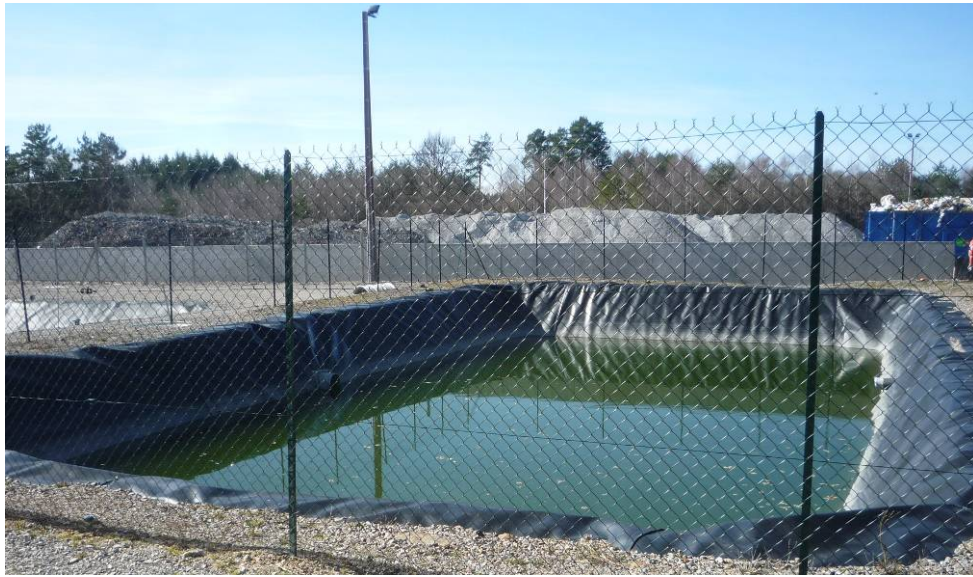
Lagune eaux industrielles 2
