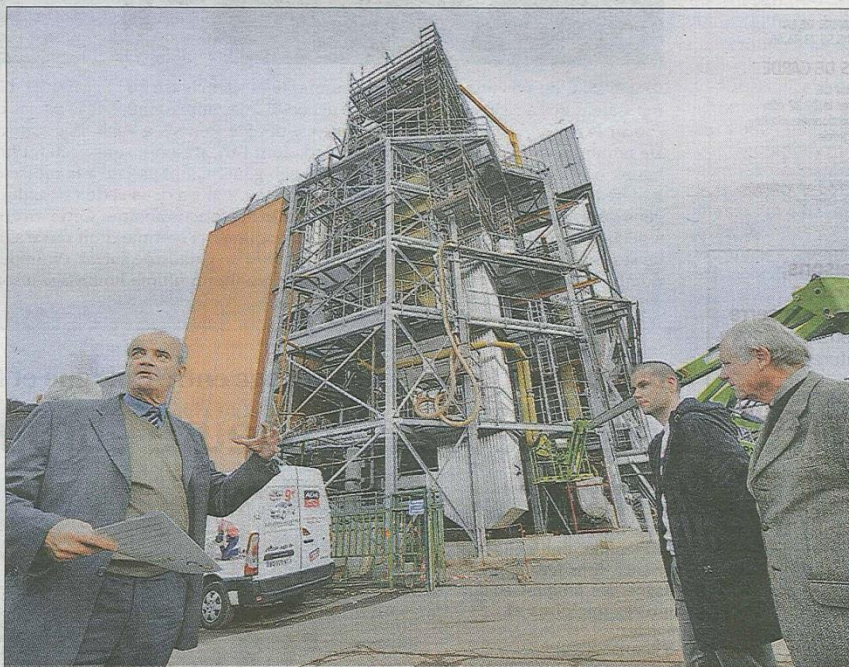
CHANTIER. Didier Fontaine, directeur d'exploitation de la Cnim (à gauche) et René Planade (à droite) font le tour des nouvelles installations de l'unité de valorisation énergétique de Saint-Pantaléon. PHOTO FRÉDÉRIC LHERPINIÈRE
