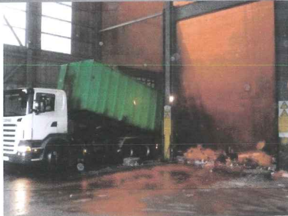
hall de réception des Ordures Ménagères
