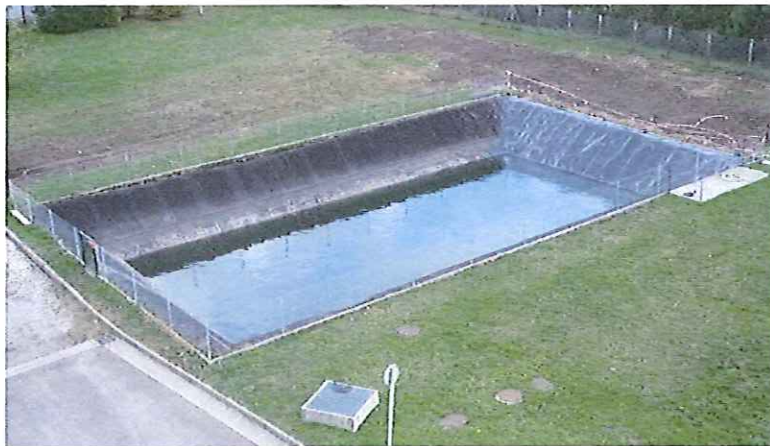
Lagune eaux incendie
