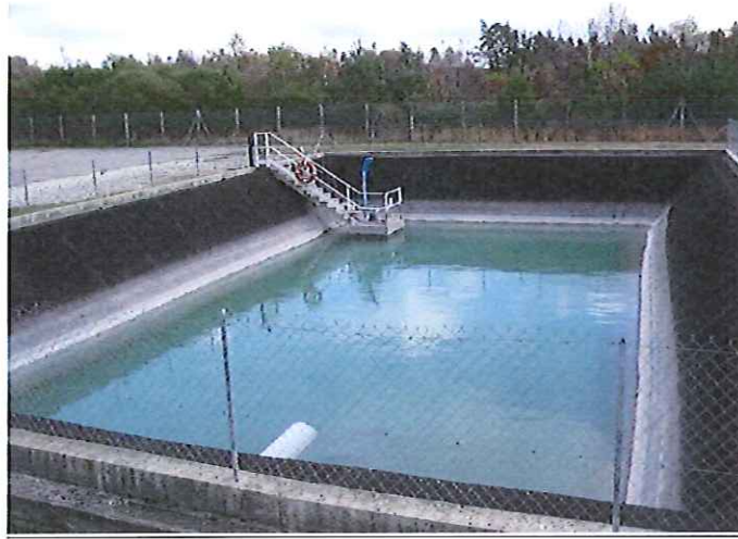
Lagune eaux industrielles
