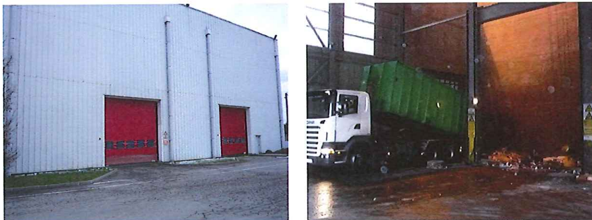
hall de réception des Ordures Ménagères
