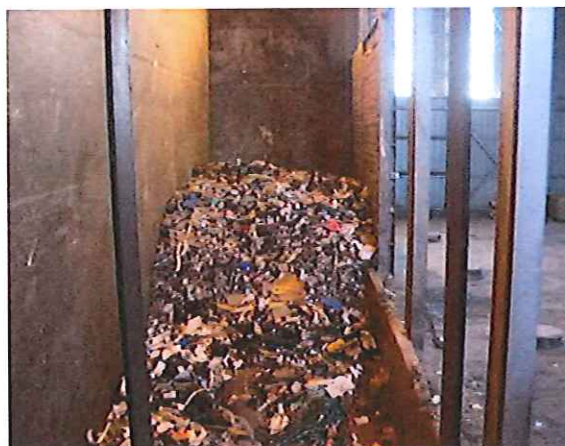
Fosse de réception des Ordures Ménagères
