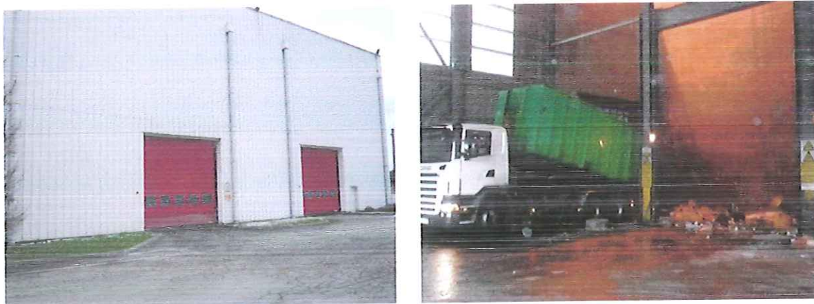
hall de réception des Ordures Ménagères
