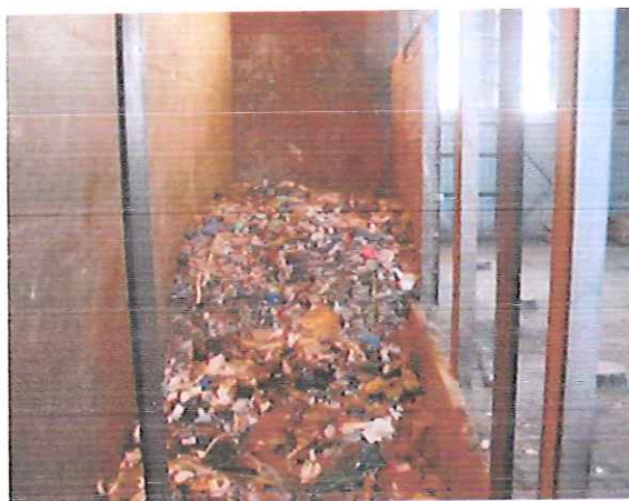
Fosse de réception des Ordures Ménagères
