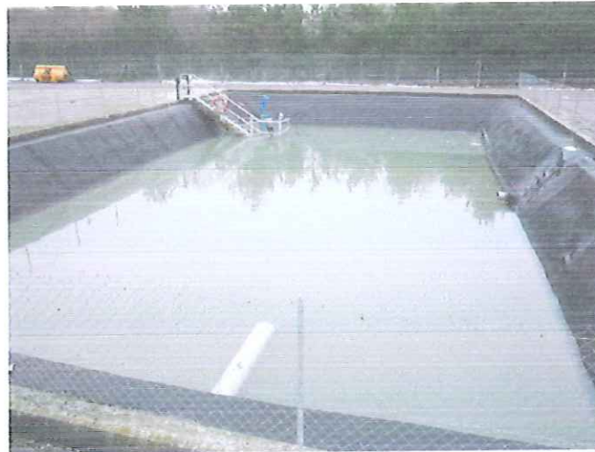
Lagune eaux industrielles 1
