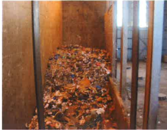
Fosse de réception des Ordures Ménagères
