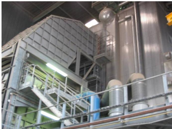
A la sortie de la chaudière la vapeur surchauffée est distribuée vers la turbine ou le contournement (en cas d'arrêt du turboalternateur). A l'intérieur de la turbine, la vapeur se
