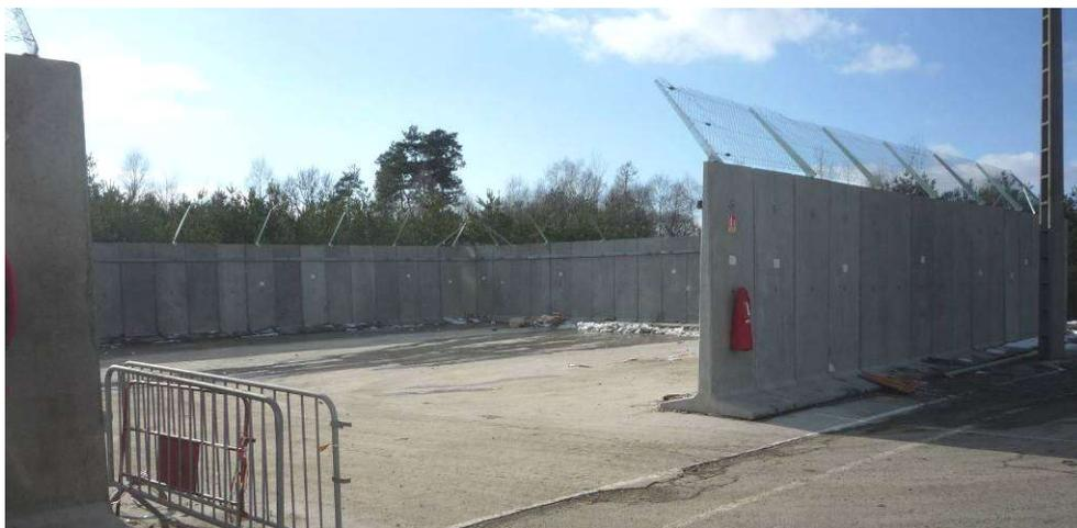
La plateforme de traitement des encombrants de déchetteries est constituée d'une dalle bétonnée, ceinturée de murs amovibles en bétons équipés à l'extrémité de grillage destiné à éviter les envolées de déchets.
