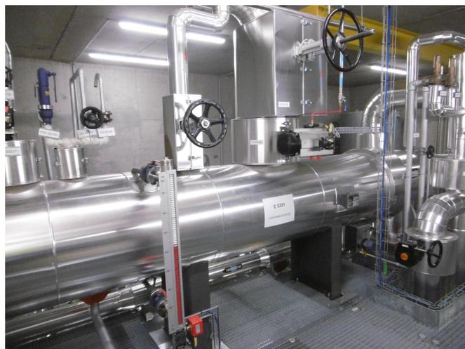
Entre la turbine et l'aérocondenseur un hydro-condenseur permet l'alimentation des serres agricoles ou Réseau de Chauffage Basse Température pour une puissance de 7.5MWh. C'est l'énergie fatale qui permet de chauffer à 50°C l'eau alimentant l'Open Buffer des serristes à l'aide de 3 pompes.
