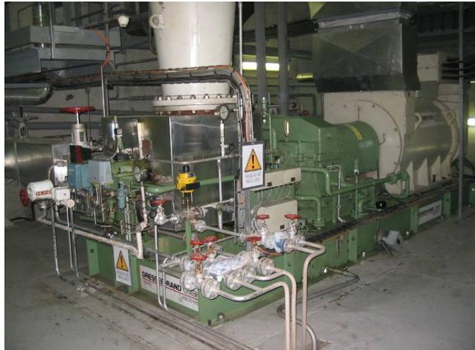
Au niveau de la turbine, un clapet de soutirage permet de prendre la vapeur détendue et d'alimenter un barillet MP/BP. Ce barillet permet l'alimentation d'un condenseur sur le départ de réseau de chaleur au niveau du local RCU. Ce condenseur sert à réchauffer l'eau en provenance de la chaufferie de Tra le Bos sur la commune d'Egletons.
