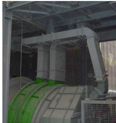
Un système de récupération de la chaleur du four permet de produire de la vapeur surchauffée au travers d'une chaudière à « tubes d'eau », à simple ballon et à circulation naturelle.
