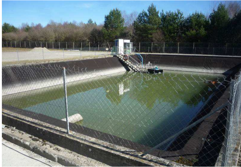
Lagune eaux industrielles 1
