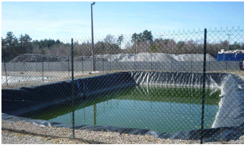
Lagune eaux industrielles 2
