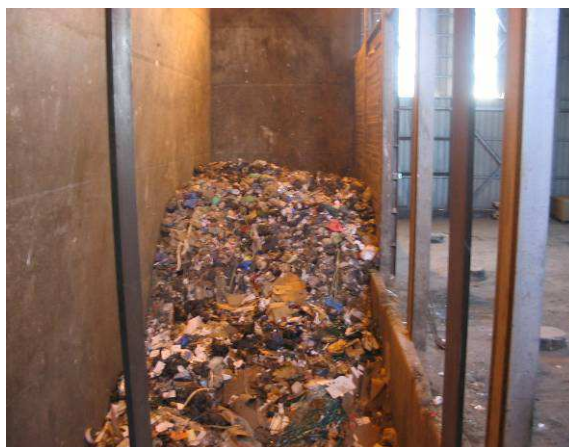
Fosse de réception des Ordures Ménagères
