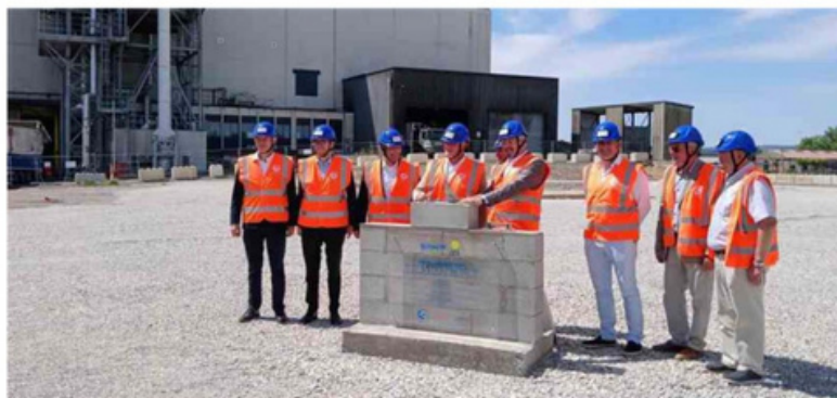
Cette nouvelle UVE pourra traiter 79 200 tonnes de déchets par an.
